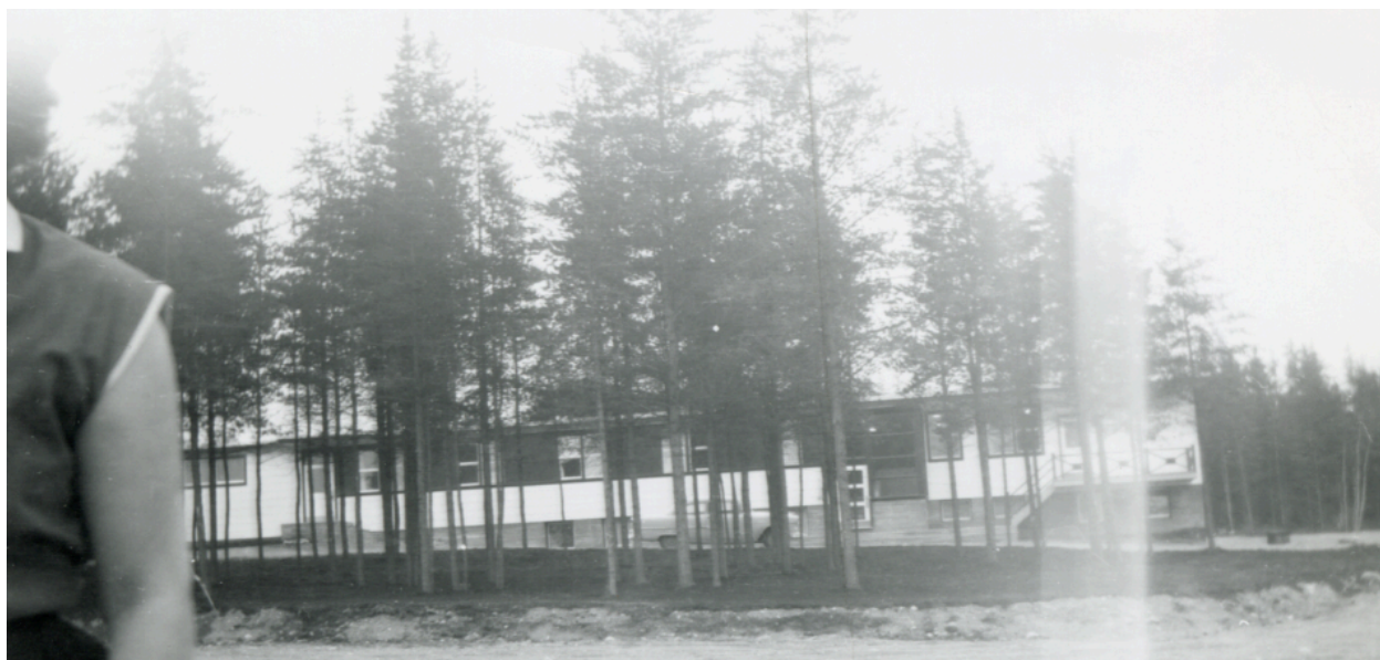
Photo : L'hôpital Opémiska de Chapais, 1957. SHBJ \ P125.S1.D6.P4
